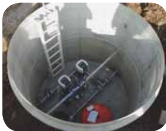
Вид станции с бустерным насосом в сухом доке
